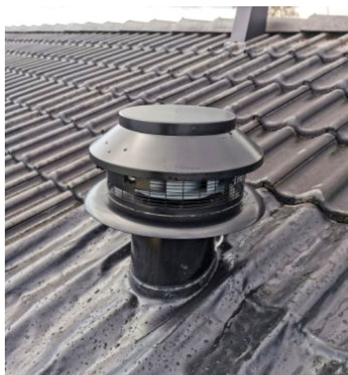
Gennemføring i pulverlakeret stål med perform inddækning
